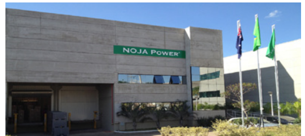
NOJA Power Do Brasil Factory Office (São Paulo)
